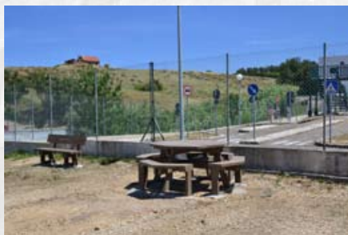
Construção de novas áreas de lazer - Arruda dos Vinhos
