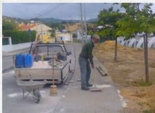
Reparação da rede viária
