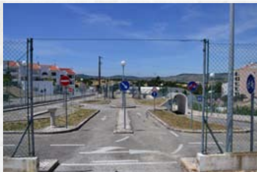
Beneficiação e abertura ao público da Escola Fixa de Trânsito
