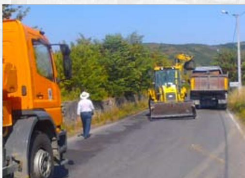
Reparação da rede viária
