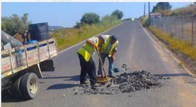
Reparação da rede de saneamento concelhia
