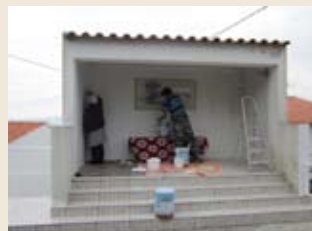
: Beneficiação dos abrigos nas paragens dos transportes públicos da freguesia (Carvalha)
