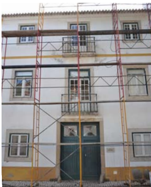
Arruda dos Vinhos : Obras de manutenção do Centro Cultural do Morgado
