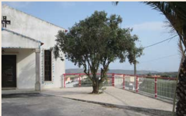
: Arranjos exteriores à capela de Adoseiros
