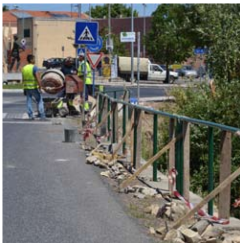
Arruda dos Vinhos : Instalação de barreira de proteção junto à rotunda Rotunda do Bombeiro
