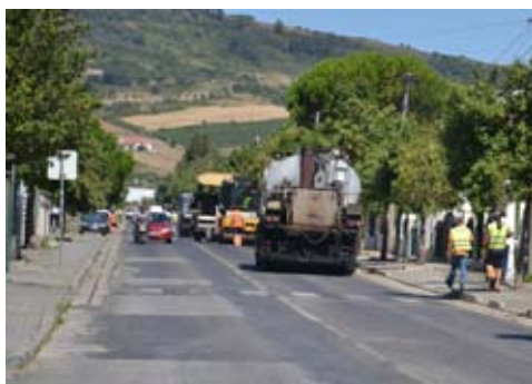
Reta da Fresca - Arruda dos Vinhos : Reparação de pavimento - intervenção da Infraestruturas de Portugal
