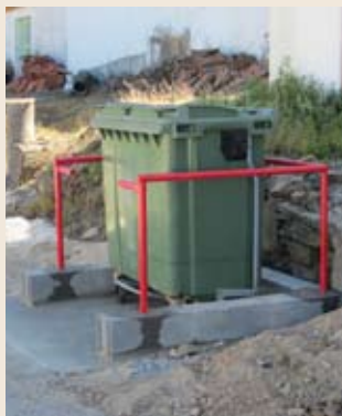
: Execução de bases para contentores dos RSU na freguesia (Carvalha)
