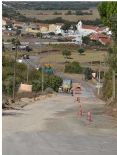
S. Tiago dos Velhos / A-do-Mourão : Reparação do CM 1232, vulgo estrada A-do-Mourão/ S. Tiago dos Velhos, abrangendo a Rua das Camadeiras e a Rua Vale Domingos (entre S. Tiago dos Velhos e o cruzamento para a Variante a A-do-Mourão)
