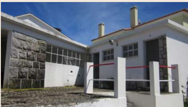
: Beneficiação dos lavadouros e WC da freguesia (A-do-Mourão)
