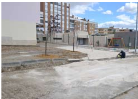
Casal do Telheiro - Arruda dos Vinhos : Construção de passeio e lugares de estacionamento
