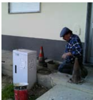
Reparação de passeios na Urbanização Casal do Telheiro
