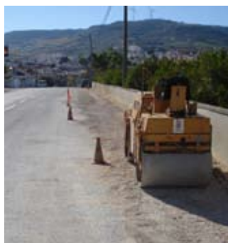
Reparação dos acessos exteriores do pavilhão Multiusos
