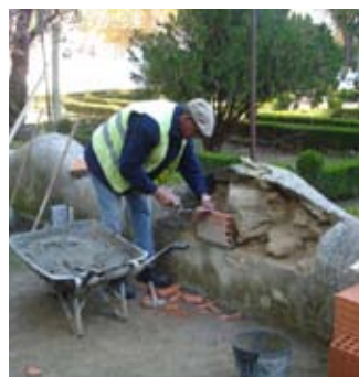
Reparação de muretes no jardim do Centro Cultural do Morgado
