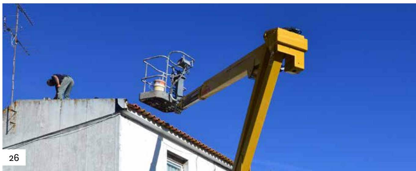
22/23 Pavimentação da estrada dos 4 caminhos / Granja | 24/25 Arranjo de parque infantil e reforço de muro junto à antiga escola, em Adoseiros | 26 Reparações no Bairro Calouste Gulbenkian
