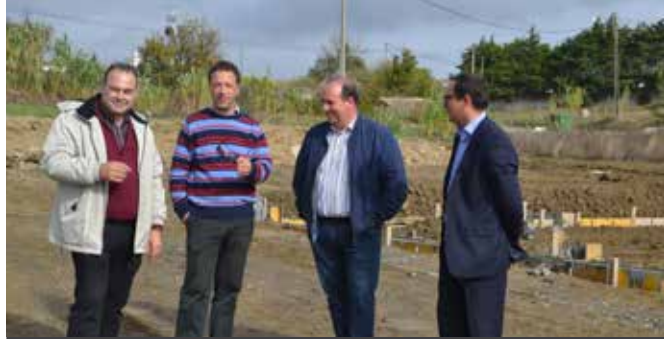
Novos investimentos na Zona Industrial das Corredouras - obra de construção de instalações das empresas Scope e Aerohélice
