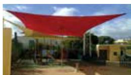
Colocação de 3 telas tensionada através de cabos de aço e esticadores.
