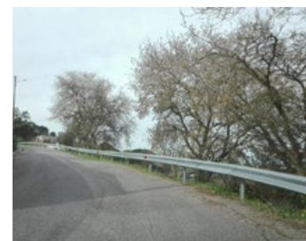
• Instalação dos Rails de proteção na Estrada da Cruz da Hipólita, com meios da Câmara Municipal
